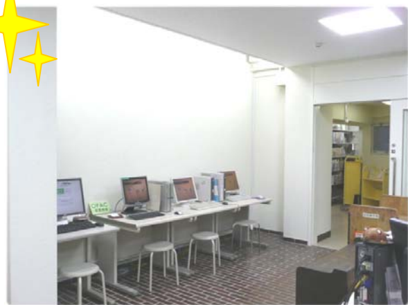
新たに耐震補強の壁ができた書庫入口
